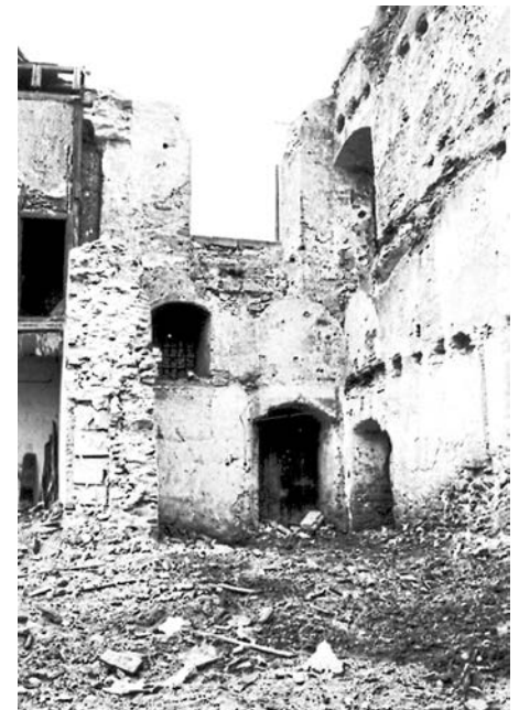
Während der Abrissarbeiten wurden Reste des Westflügels sichtbar.
