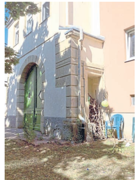
Die rechte Risalitecke mit der zugemauerten Seitentür, 2019.
