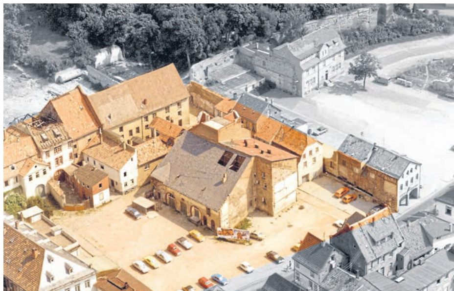
Der Schlossbereich während der Abrissarbeiten 1978 farblich markiert.
