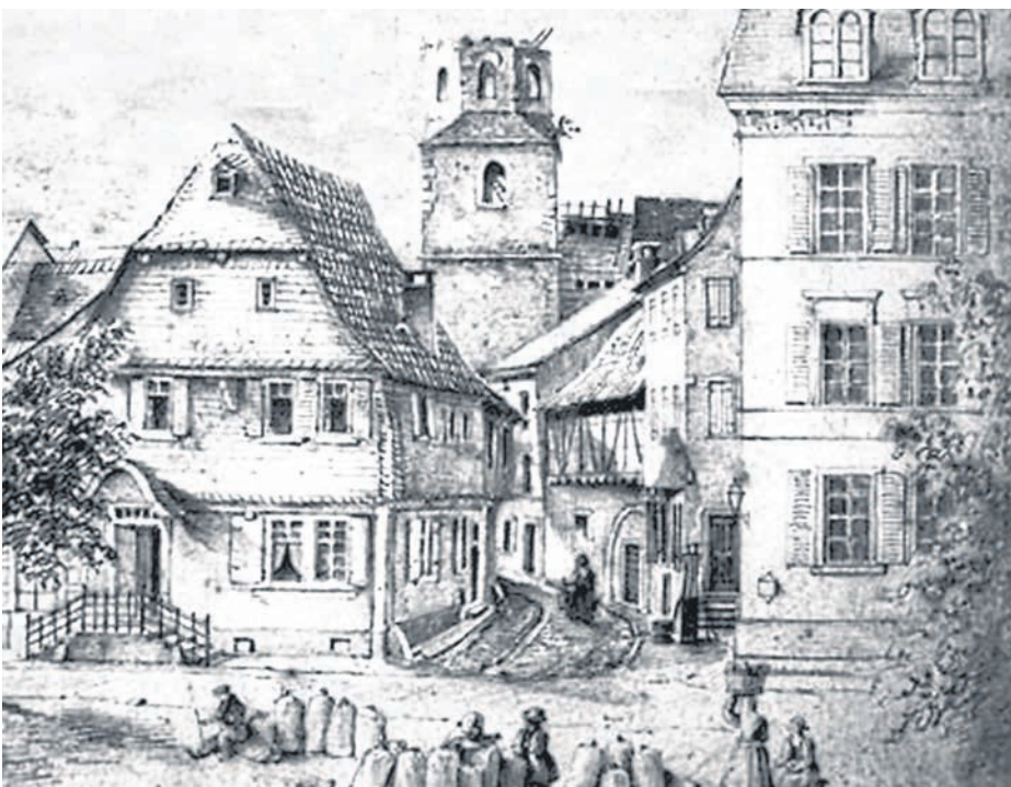
Der zerstörte Barockturm der Wilhelmskirche 1865.
