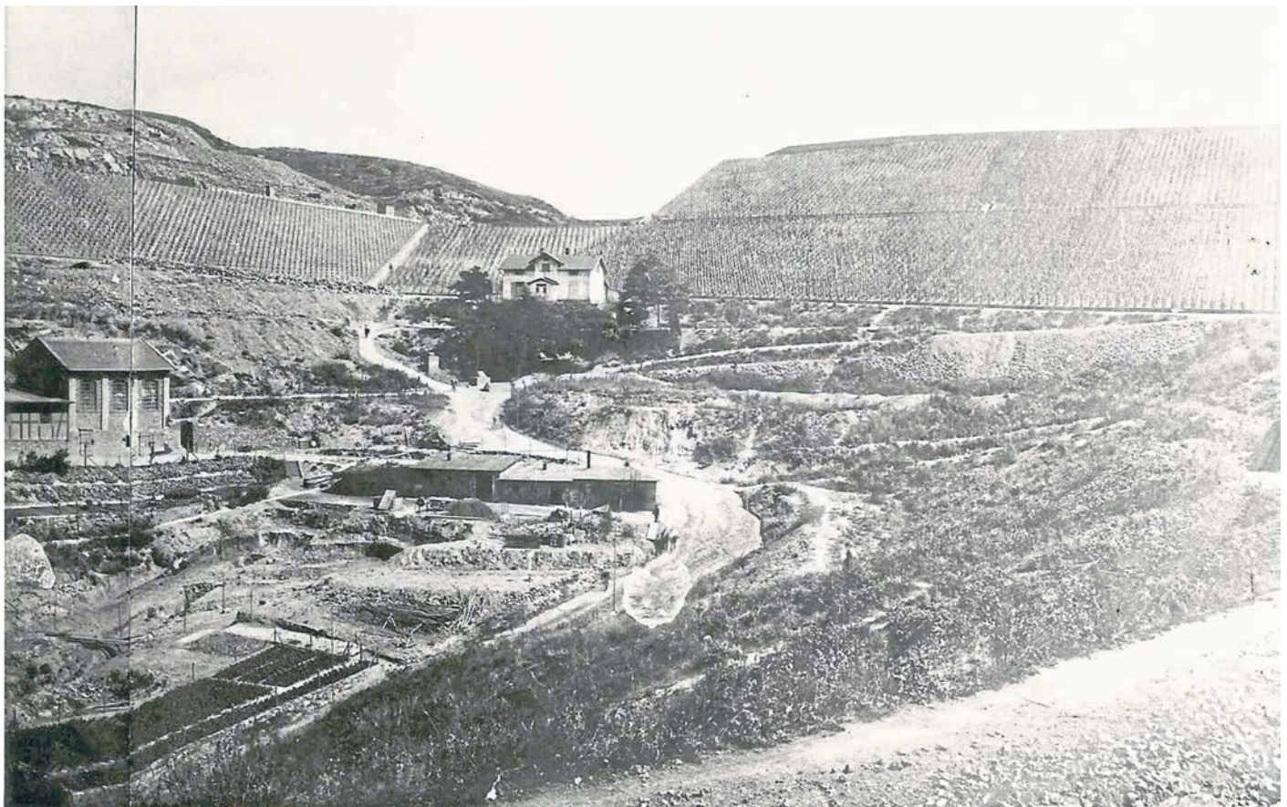
Baustelle der ehemaligen Domäne.
