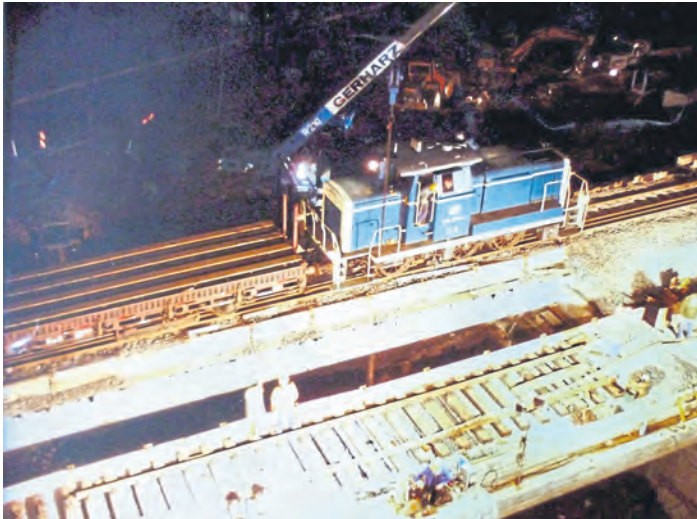
Einschub der betonierten Brückenplatten auf die neuen Widerlager.
