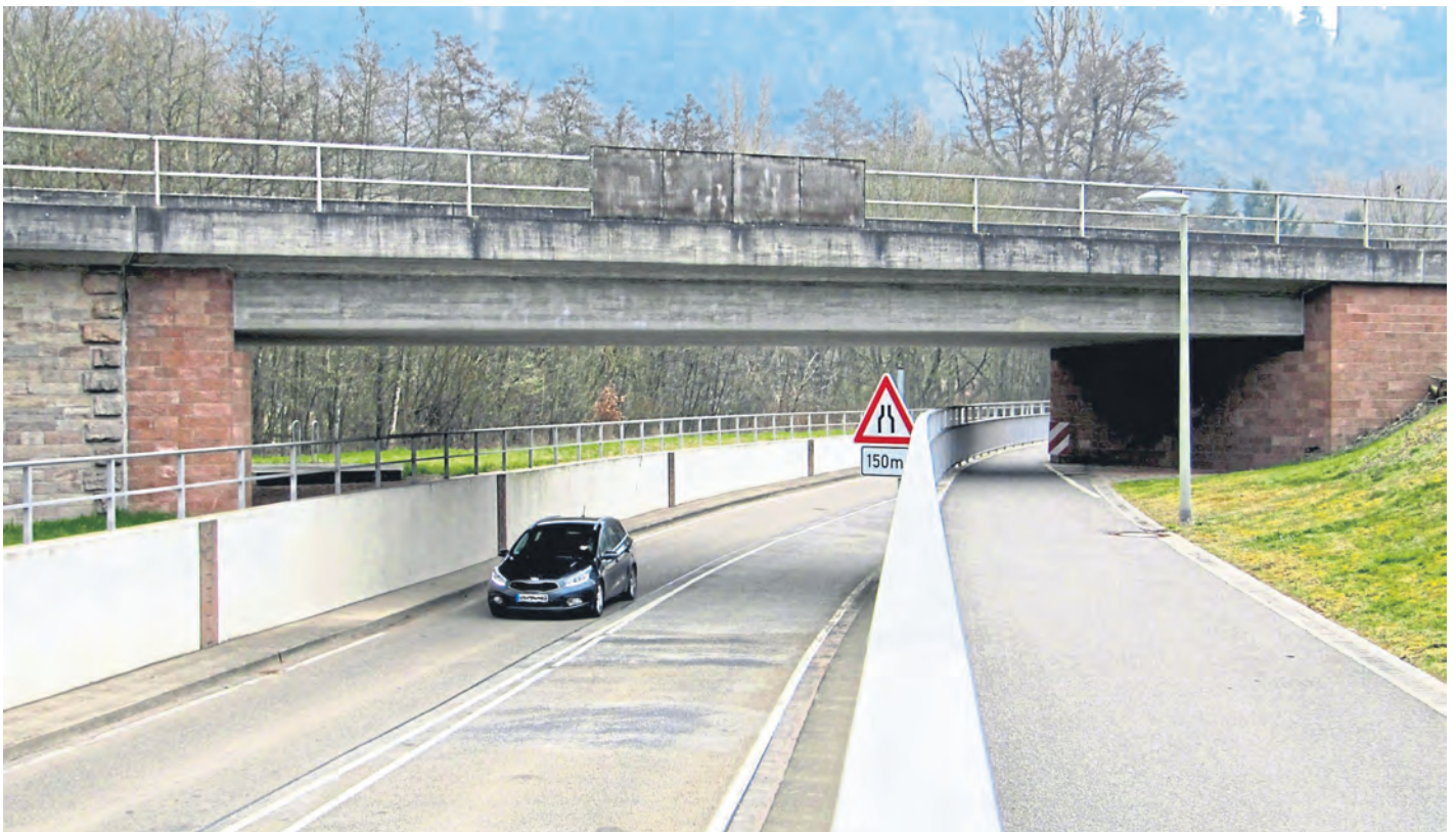
Die fertige Unterführung der B 48 in Altenbamberg.
