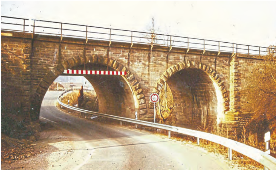
Die B 48 ist provisorisch unter die Alsenzbrücke umgeleitet.
