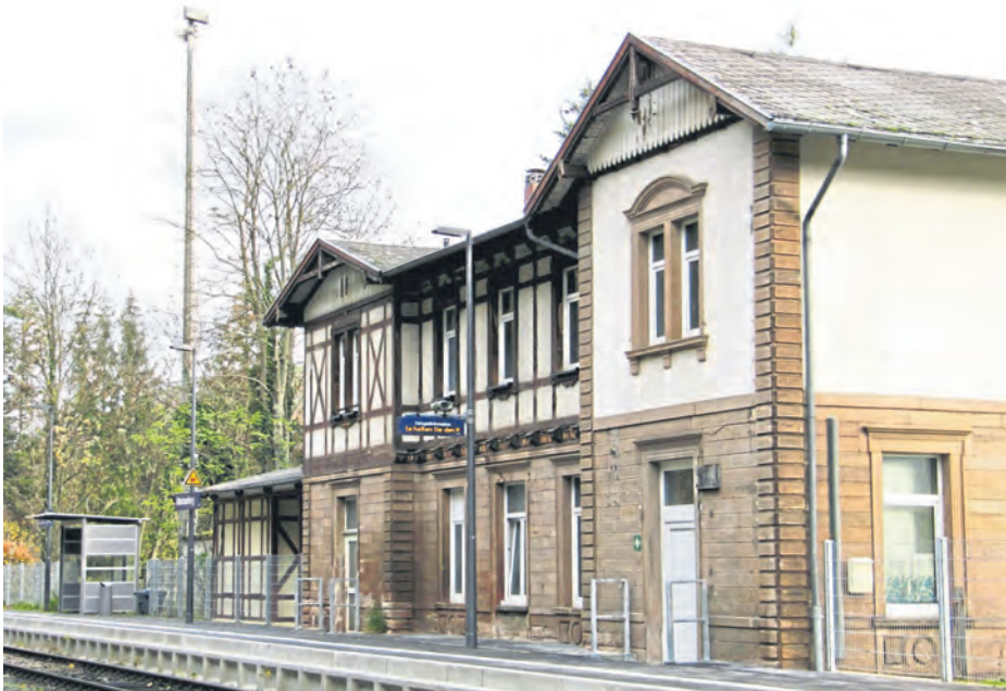
Der alte Bahnhof von Altenbamburg.
