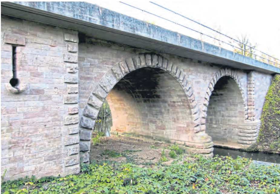
Die Altenbamburger Eisenbahnbrücke über die Alsenz mit der neuen Fahrbahnplatte.
