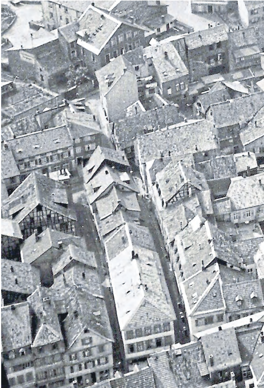
Der Baublock zwischen Michel-Mort- und Metzgergasse um 1960. Oben Mitte: Gerbergasse 19.
