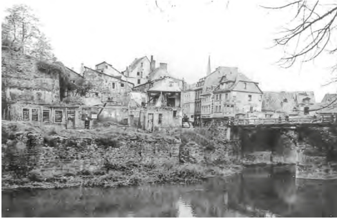
Die Zerstörungen in der Klappergasse stammen ebenfalls von dem durchschlagenden, aber trotzdem missglückten und bis heute wegen seiner Zerstörungskraft bedauerlichen Versuch, den amerikanischen Vormarsch und Übergang über die Nahe in die Stadtmitte zu verhindern.
