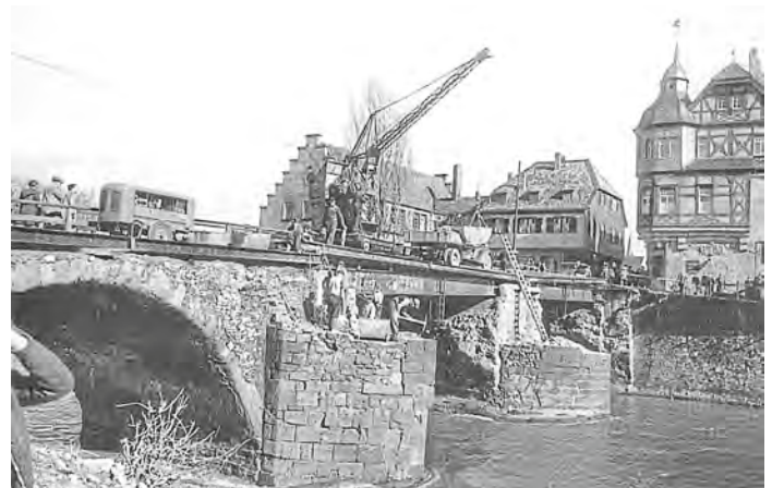
Arbeiten auf und an der „Alten Nahebrücke“ bei den Renovierungen 1955.
