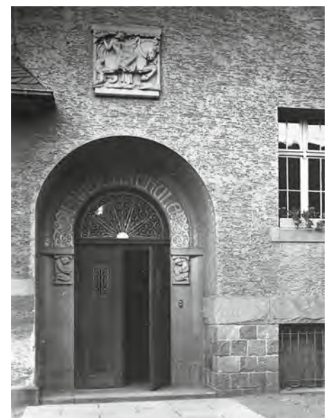
Portal am Eingang zur Frauenschule.
