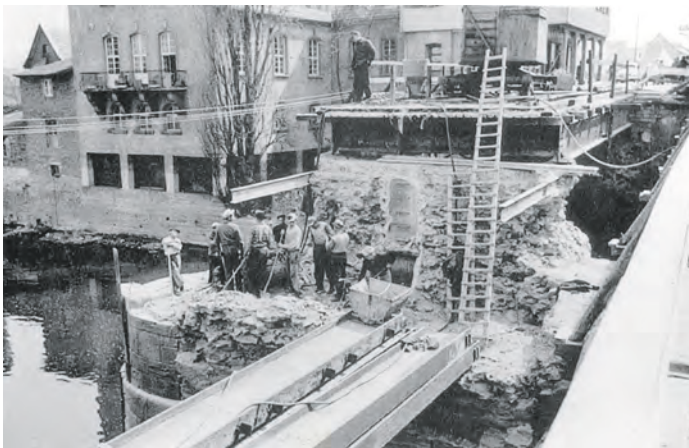
Das Fundament der „Alten Nahebrücke“ bei den Renovierungen 1955.
