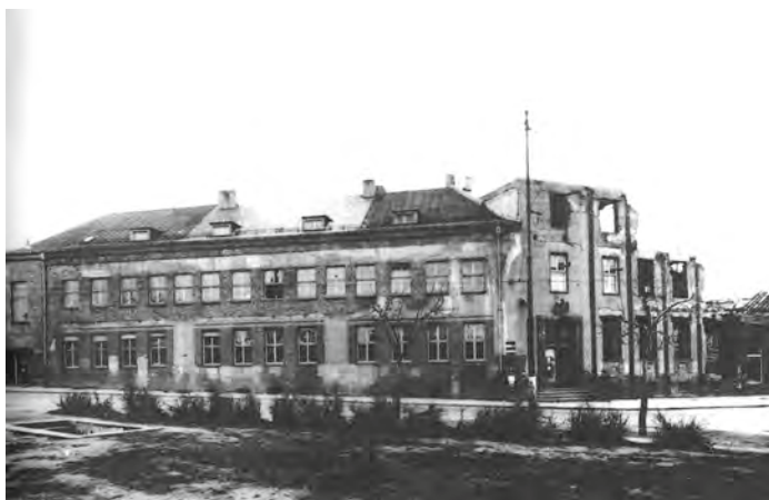
Die damalige Hauptpost, heute: Wilhelmstraße 88, nach dem 2. Januar 1945. Im Vordergrund links ist der Bahnhofs-Bunker erkennbar.
