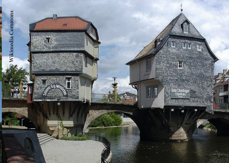
Bad Kreuznacher Wahrzeichen: Die Brückenhäuser.
